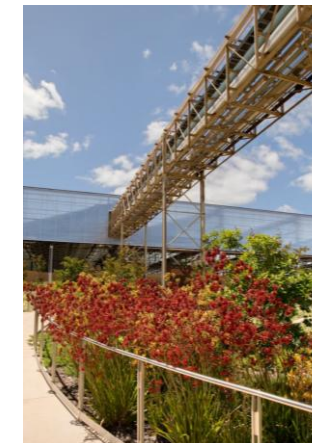
Gray Water Reuse
